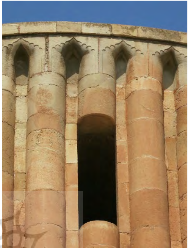
تصویر ۱۴. نمای سنگی استوانه بنا به همراه نورگیر تعبیه شده.
