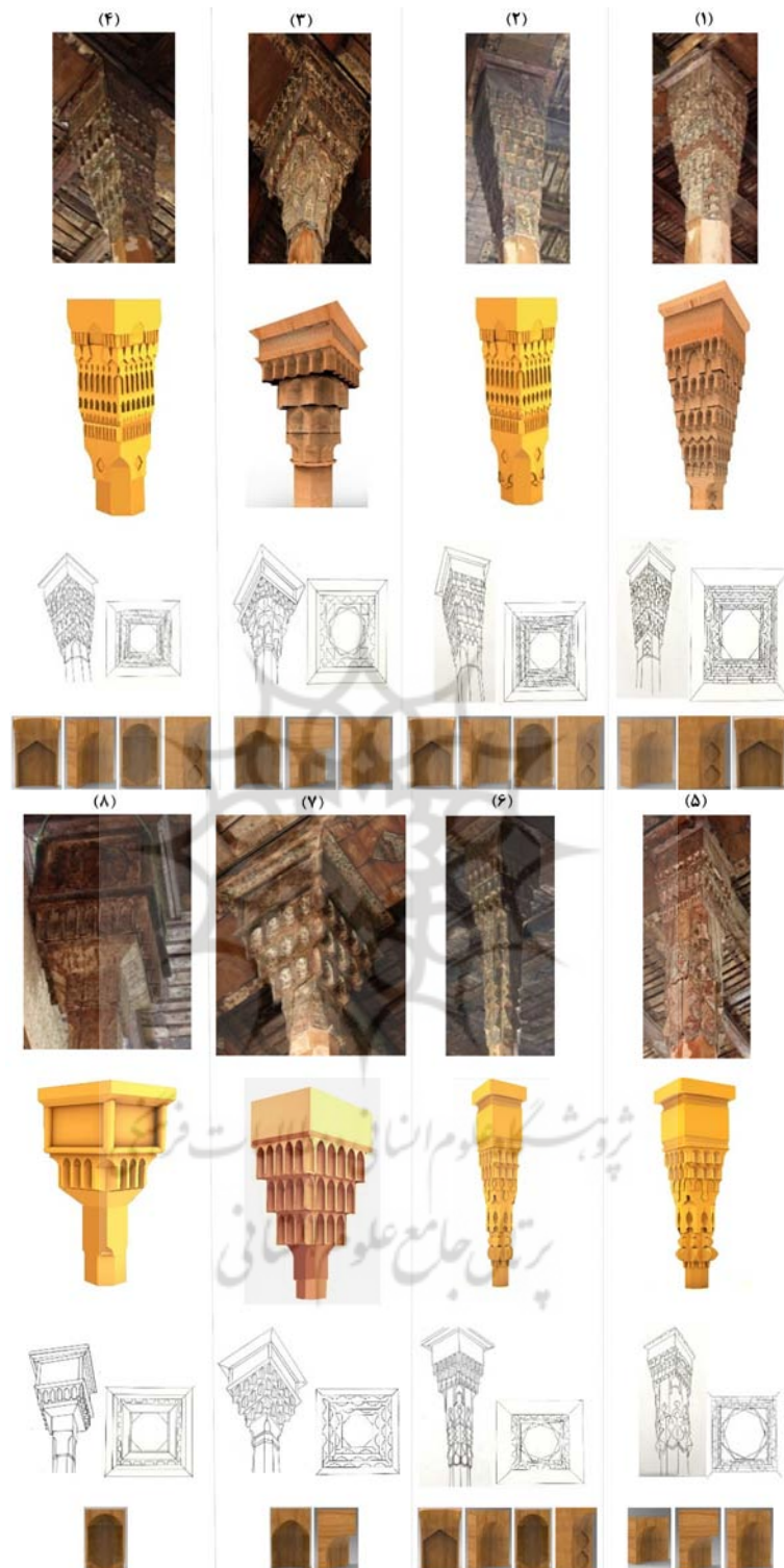
تصویر ۲. معرفی سرستون‌های مسجد مهرآباد بناب؛ قطعات به صورت قامه‌های مثلثی برش داده شده و آلات به صورت چند تکه روی هم قرار گرفته‌اند. مأخذ: نگارندگان.
