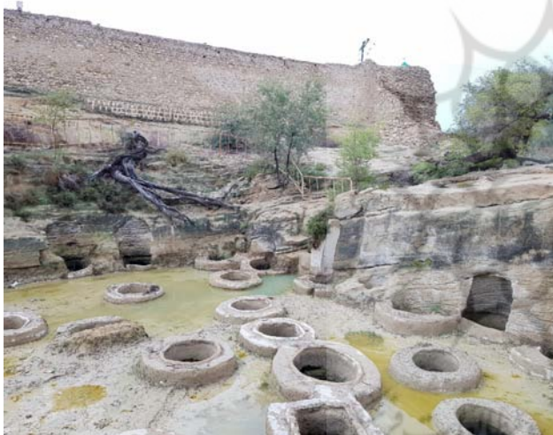
تصویر ۲. تلوهای ذخیره آب باران به‌عنوان مظاهر فناوری بهره‌مندی از خدمات اکوسیستم، جزیره قشم، بندر لافت. مأخذ: آرشیو نگارنده.
