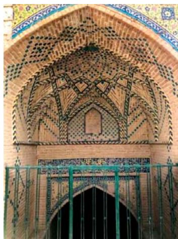
تصویر ۵. کاربرد کاشی هفت رنگ و آجر لعابدار در تزیینات سردر آب انبار گذر باباولی کاشان، ۱۲۳۳ ه.ق، مأخذ: نگارندگان
