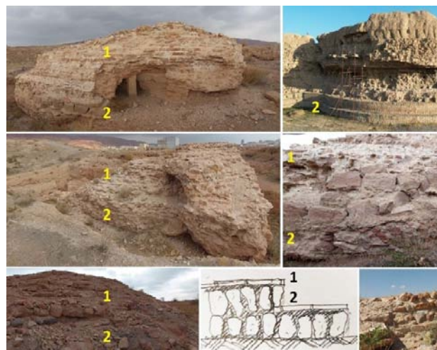
تصویر ۸. چگونگی چیدمان و کاربست آجر و سنگ و ملات آهکی برای پیشگیری از رطوبت بالا رونده در سازه پلکانی ربع‌رشیدی و مقایسه آن‌ها با برج بزرگ جنوبی، شماره ۱: آجرکاری، شماره ۲: سنگ‌چینی. مأخذ: نگارندگان.
