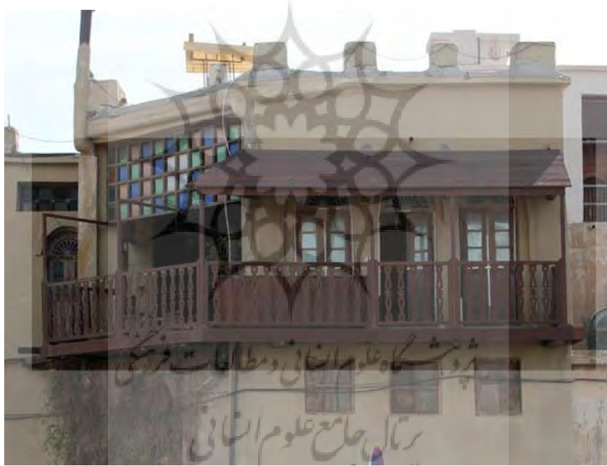
شکل ۵: طارمه و شناشیل خانه مسکونی در نواحی ساحلی مناطق گرم و مرطوب، بوشهر
