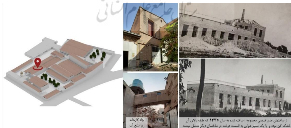
شکل ۷: ساختمان رنگرزی کارخانه برق لاهه (Barq-e-Lame, 2020).
