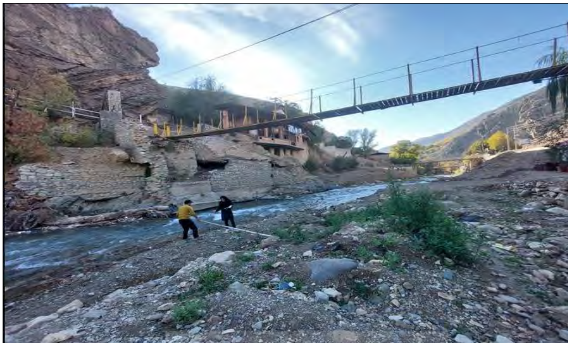
شکل ۶. تصویری از بازه فرسایش پذیری در کناره چپ و رسوبگذار در کناره راست رودخانه جاجرود از رودک تا کلیگون (بازه ۳)
