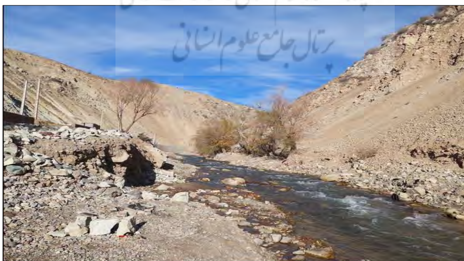
شکل ۵. تصویری از بازه فرسایش پذیر رودخانه جاجرود، از امین آباد تا رودک (بازه ۲)
