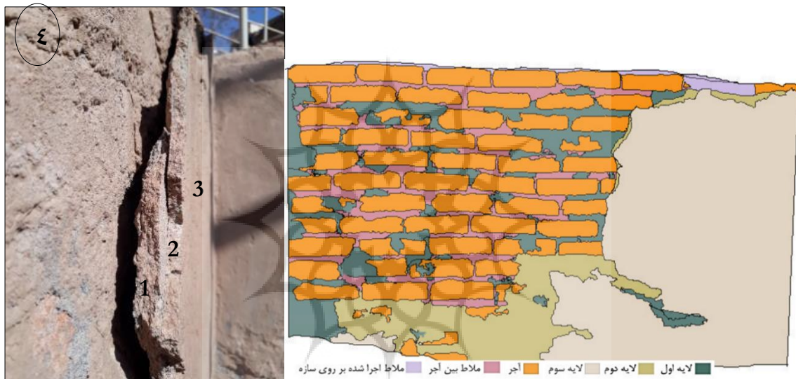
شکل ۵: لایه‌های اندود مورد مطالعه در سازه موسوم به سقايه ربع رشیدی، مشخص شدن محل نمونه‌های مطالعاتی ۱ الی ۴
