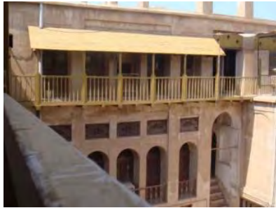
تصویر شماره ۷- شناشیر مسقف (همان)
