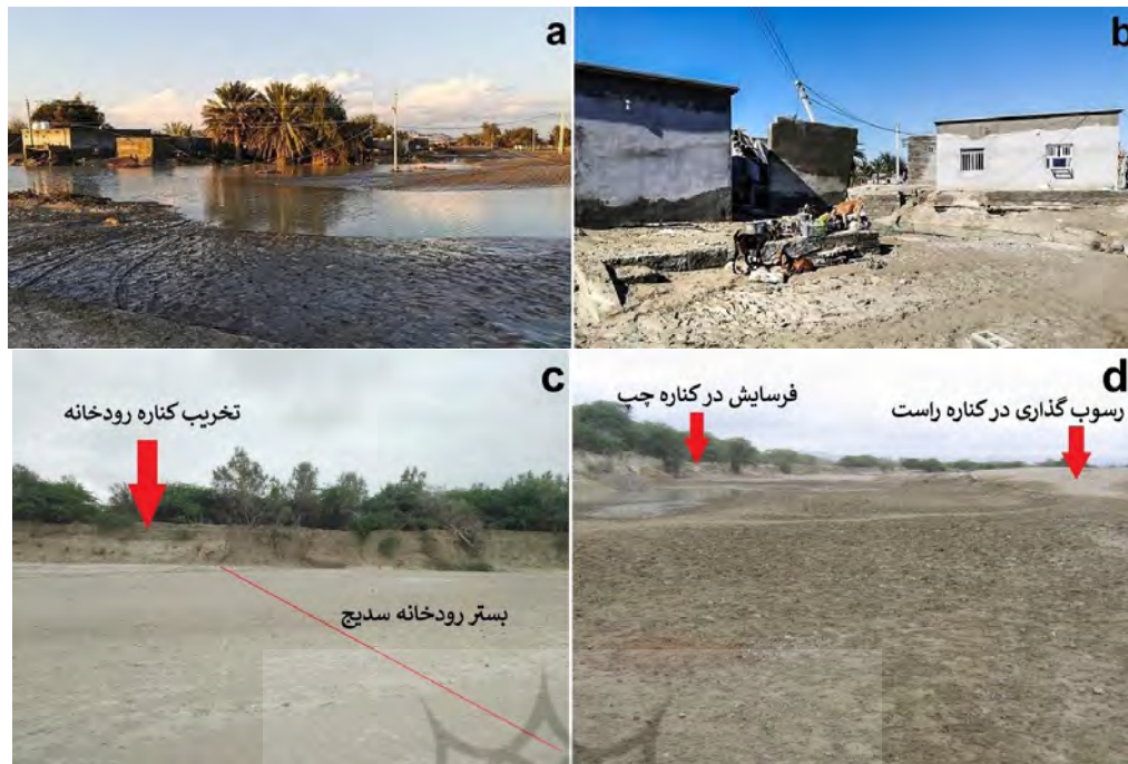
شکل ۴. a, b: آب‌گرفتگی و تخریب مناطق مسکونی روستای سدیج در بازه A (منبع: شورای روستای سدیج)، c, d: تخریب کناره‌های رودخانه سدیج در اثر سیلاب‌ها در بازه B
