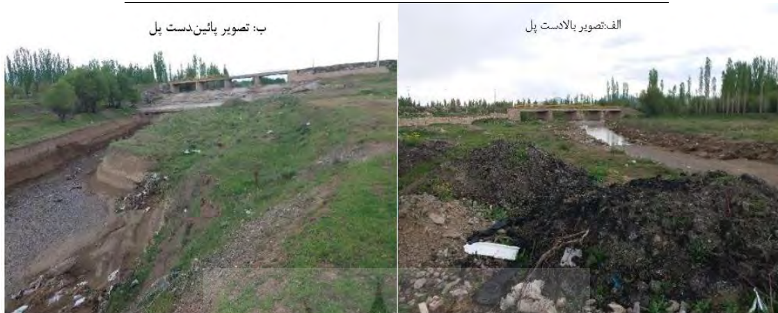
شکل ۸- تصاویر پل سرنق.
