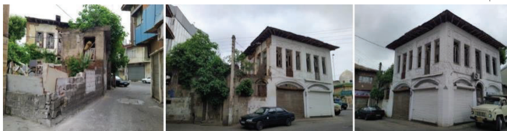
شکل ۱۳. تصاویر بیرونی خانه حاجی سیف
