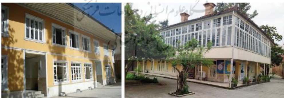
شکل ۴. نمای شمالی و غربی (راست) و نمای جنوبی (چپ) خانه ابریشمی
