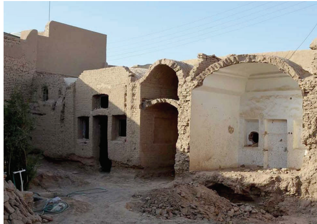
شکل ۲۲. وضع فعلی اتاق‌های ضلع شرقی.
