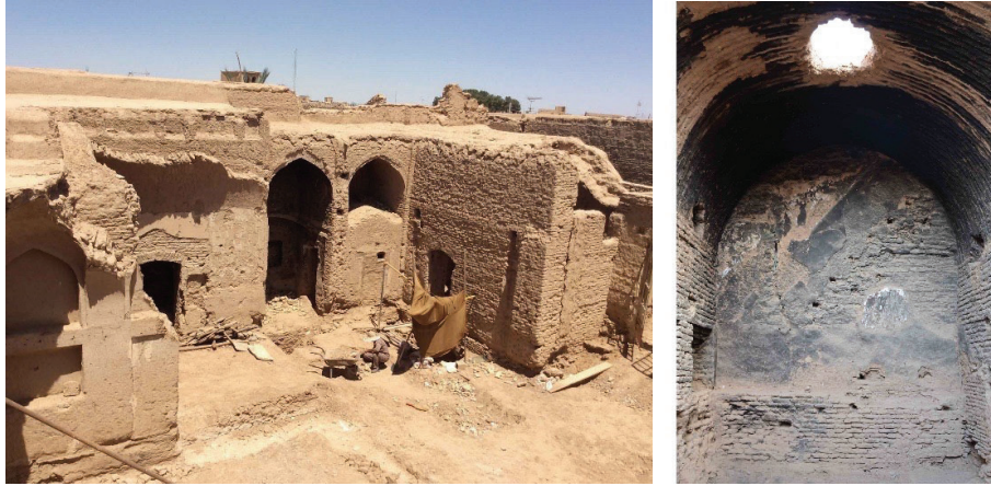
شکل های ۱۶ و ۱۷. چپ: حجم افزوده اتاق شمالی که به ضلع غربی متصل شده و ضلع شرقی که از بین رفته است. راست: داخل اتاق شمالی.
