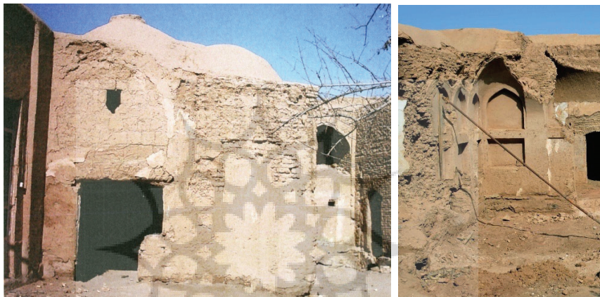
شکل ۲۰ و ۲۱. چپ: اتاق مجاور شرق ایوان که هنگام تعمیرات افزوده شده است (گرگویی، ۱۳۸۴)، راست: همان اتاق پس از خرابی.
