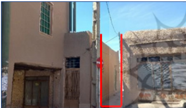
شکل ۱۸. کیفیت حفظ تناسب و محصوریت فضای شهری پیرامون در تکیه زنجیری شاهرود. ماخذ: نگارندگان
