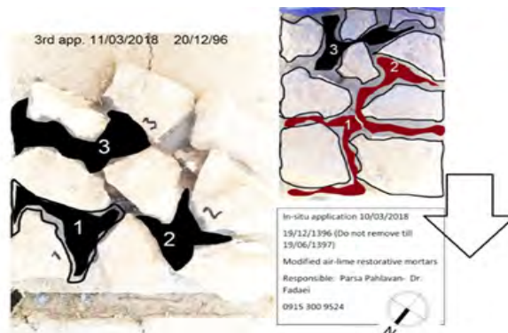
شکل ۷. سیمولاسیون به‌وسیله چینی‌سنگ‌ها و پرکردن آنها با انواع ملات‌های طراحی‌شده در سایت
