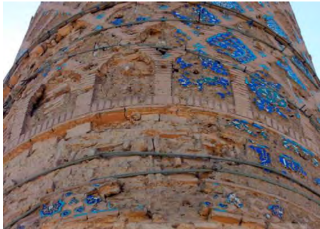
شکل ۲۳. جزئیات تزئینات کاشی و آجری مناره
