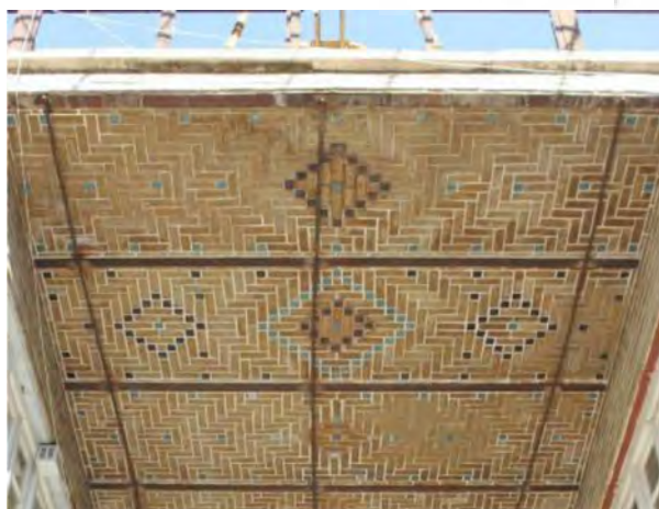
تصویر ۱۴. شیوه‌های متنوع آجرچینی سقف ترکیبی با آجر لعاب‌دار؛ پاسازامجدی قم.
