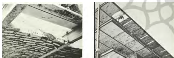
تصویر ۸. تیرآهن و طاق ضربی متداول در مکزیک که همانند ایران، بدون قالب و به حالت پر زده می‌شود. مأخذ: (کراال و رنسام، ۱۹۶۶، ۱۷)
