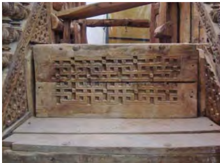
شکل ۶: فروریختن سه پله انتهایی و استفاده از میخ‌های فلزی در منبر فریزهند و بست‌های فلزی منبر فریزهند (عکس: نگارنده ۱۳۹۳)
