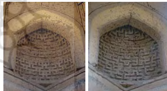
شکل ۱۱: آجرکاری سکنج‌های آرامگاه سنگ بست (صالحی کاخکی و موسی تبار، ۱۳۹۱: ۱۱۳)
