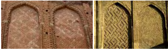
شکل ۹: طرح‌های آجری متفاوت به کار رفته در گنبد سرخ (سمت راست) (URL 6) و گنبد علویان (سمت چپ) (URL 7).
