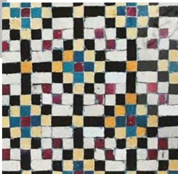
تصویر ۳: بخشی از قاب کاشی معرق و معقلی ایوان شرقی امامزاده زید تهران با قطعات کاشی نکرنگ قرمز- صورتی طلا (ریاضی، ۱۳۹۵: ۱۱۱)
