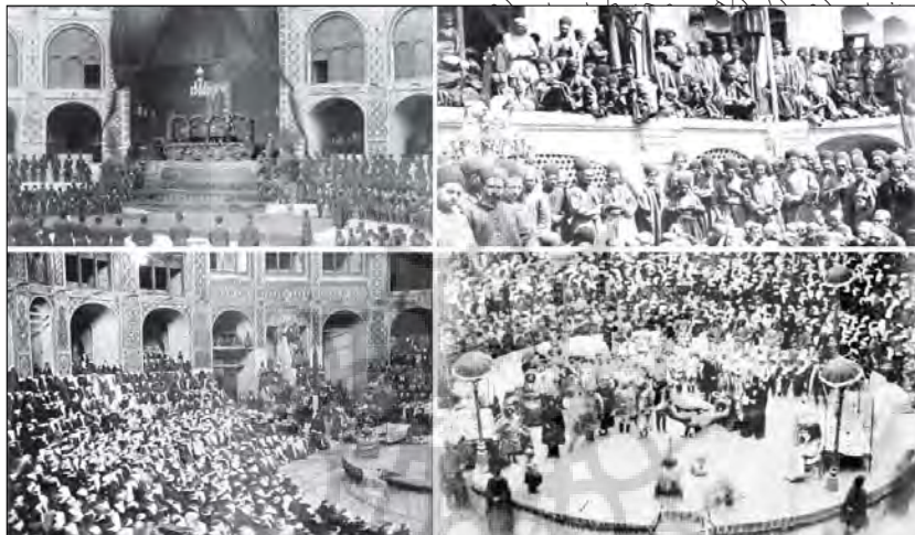
تصویر ۳. نمای داخلی تکیه دولت در زمان اجرای تعزیه
