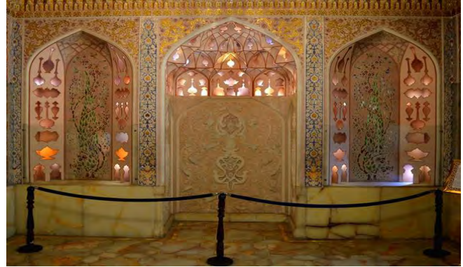
تصویر ۱۳. آرایه‌های تنگ‌بری، کپ‌بری و مقرنس در طاقچه‌ها و محراب اتاق اصفهانی‌ها مقرنس‌های سه‌پایه‌ای با روکش طلا در حاشیه سقف. منبع: نگارندگان.
