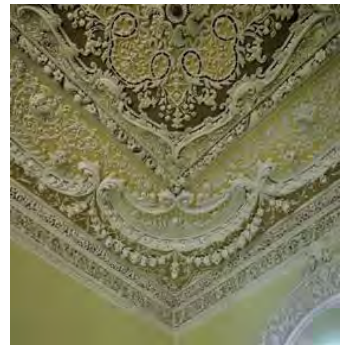
تصویر ۱۰. به‌کارگیری تکنیک‌های برهشته و نیم‌برجسته در سقف فضاهای داخلی مختلف بنا. منبع: نگارندگان.
