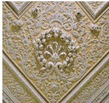
تصویر ۱۰. به‌کارگیری تکنیک‌های برهشته و نیم‌برجسته در سقف فضاهای داخلی مختلف بنا. منبع: نگارندگان.
