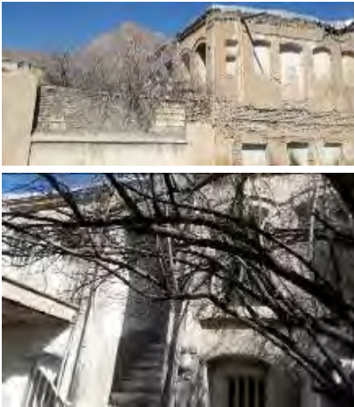
مساحت ۱۶۰ متر مربع، دارای یک ورودی، یک راه ارتباطی با همسایه مجاور در جبهه شرقی، فاقد دالان و پیرنشین و زیرزمین، جبهه شمالی دوطبقه و سایر جبهه‌ها یک طبق.
