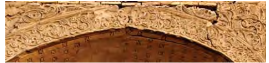
تصویر ۹. لچک طاق‌نمای ضلع غربی گنبدخانه، مأخذ: همان
