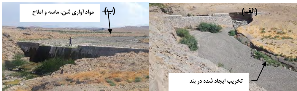
شکل (۱۰): (الف) - پر شدن بند (موقعیت ۱) - (ب) تخریب قسمتی از بند (موقعیت ۳ در نقشه ۱)
