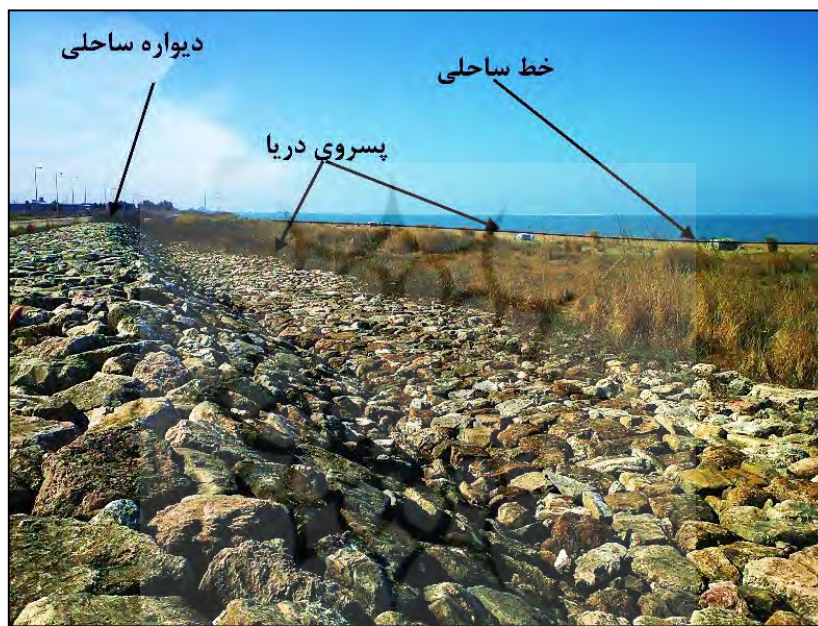
شکل (۱۲): نمونه‌ای از احداث دیواره‌ی ساحلی در گذشته جهت محافظت از ساحل و پسروی آب دریای خزر Fig (12): An example of the construction of a breakwater in the past to protect the coast and water retreat of the Caspian Sea
