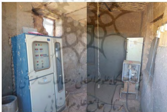
شکل (۲) نمونه‌ای از کنتورهای هوشمند آب و برق نصب شده در صفی‌آباد (بازدیدهای میدانی پژوهشگران)
