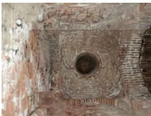
تصویر ۹) پوشش پاشیر آب انبار بالا (نگارنده، ۱۳۹۲)
