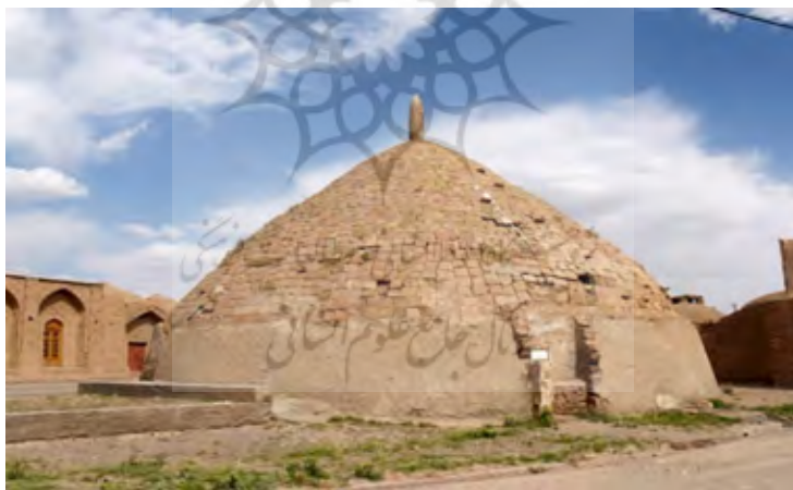
تصویر ۵) پوشش مخزن آب انبار فاضل خانی قبل از مرمت
