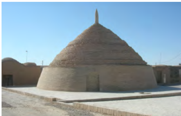
تصویر ۶) پوشش مخزن آب انبار فاضل خانی بعد از مرمت (نگارنده، ۱۳۹۱)
