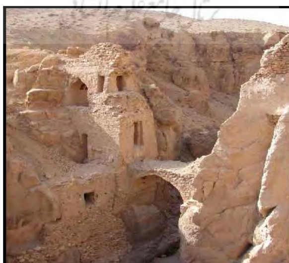
تصویر (۱۳) دور نمای پل های ترناو
