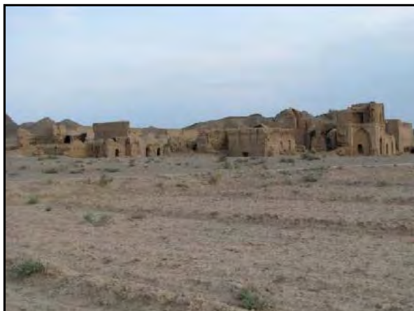
تصویر ۸) نمای جنوب شرقی قلعه طرجد
