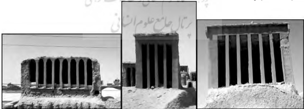
شکل ۱۸) گونه‌شناختی بادگیرها در خور براساس فرم دهانه آن مربع، مستطیل عمودی و مستطیل افقی
