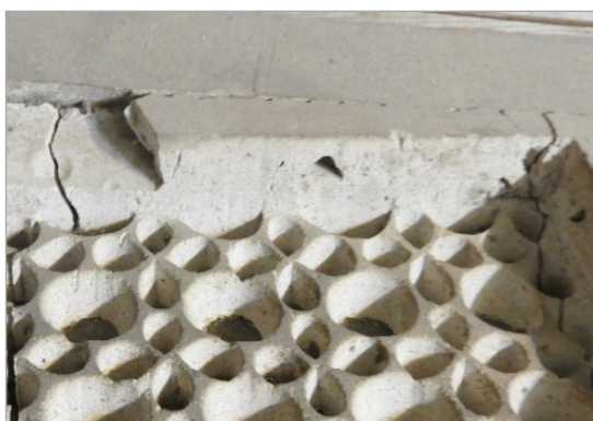
تصویر ۸. جزئیات پنجره گچی از مقطع: (الف) سطح فرورفته قاب چوبی برای اتصال بهتر گچ، عدم وجود چوب یا آرماتور درون بازوهای گچی، (ب) دولایه مجزای زیر و رو در بخش شکستگی و تخلخل و حباب تصویر گرفته در گچ رویی
