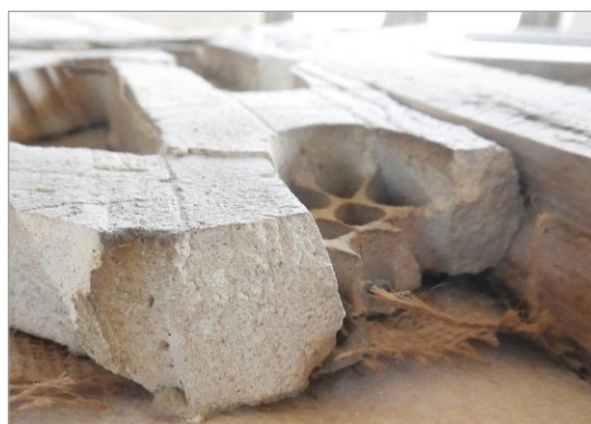
تصویر ۸. جزئیات پنجره گچی از مقطع: (الف) سطح فرورفته قاب چوبی برای اتصال بهتر گچ، عدم وجود چوب یا آرماتور درون بازوهای گچی، (ب) دولایه مجزای زیر و رو در بخش شکستگی و تخلخل و حباب تصویر گرفته در گچ رویی
