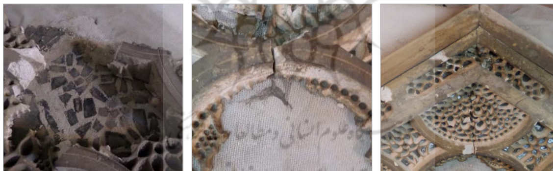
تصویر ۷. جزئیات مشخص روی پنجره گچی: قاب چوبی متصل به گچ (الف)، دواپر نقر شده با پرگار روی سطح لایه دوم (ب) و ملاط بین شیشه‌ها در قسمت فروریخته مشبک (ج)
