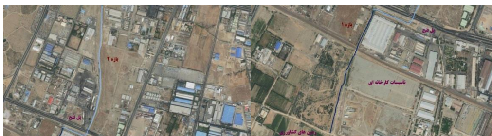
شکل (۴). تصویر هوایی مسیر بازه ۱
