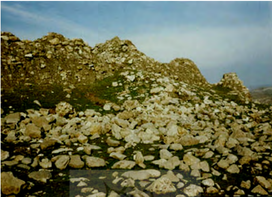
تصویر ۷. نمای دیواره جنوبی و لاشه‌سنگ‌های ریخته دیوارهای آن
