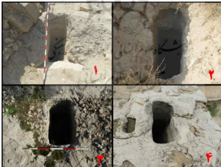
شکل ۷. میله چاه‌های قنات در دشت فیروزآباد (شماره‌های ۱ و ۲)، دشت داراب (شماره ۳)، بندر سیراف (شماره ۴)
