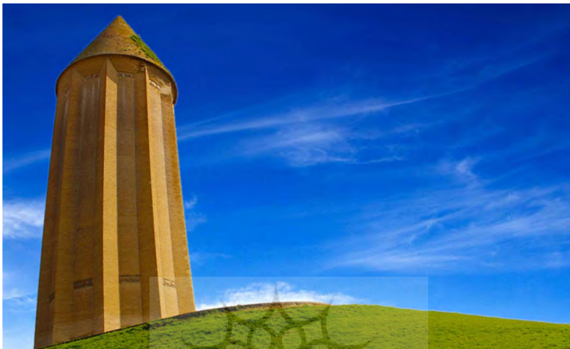
شکل ۱. نمایی از برج تاریخی گنبد کاووس
