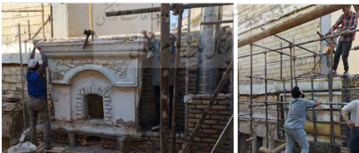
شکل ۲۸. جابجایی با استفاده از جرثقیل و ایجاد ریل با چوب برای انتقال
