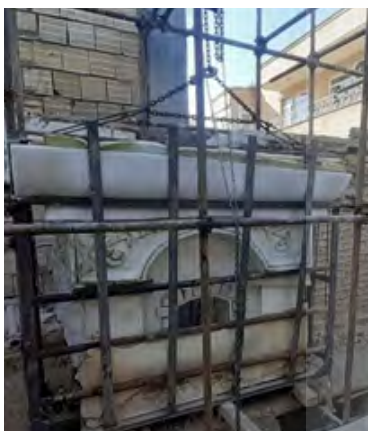
شکل ۲۳. خالی نمودن پشت کار و استحکام با گچ زنده شکل ۲۴: اتصال اثر بسته بندی شده به سازه نگهبان شکل ۲۵. مهار اثر بعد از بسته بندی کامل برای تخلیه پشت کار (از راست به چپ)
