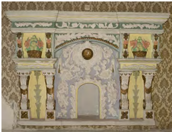
شکل ۵. شومینه اتاق شمال شرق، طبقه اول
