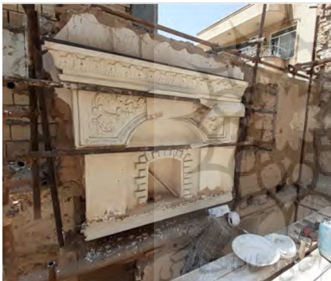
شکل ۱۴. شروع تثبیت لایه های زیرین شومینه با گچ زنده. شکل ۱۵. ایجاد لایه محافظ با گچ زنده برای قرارگیری قاب فلزی به عنوان بستر (از راست به چپ)
