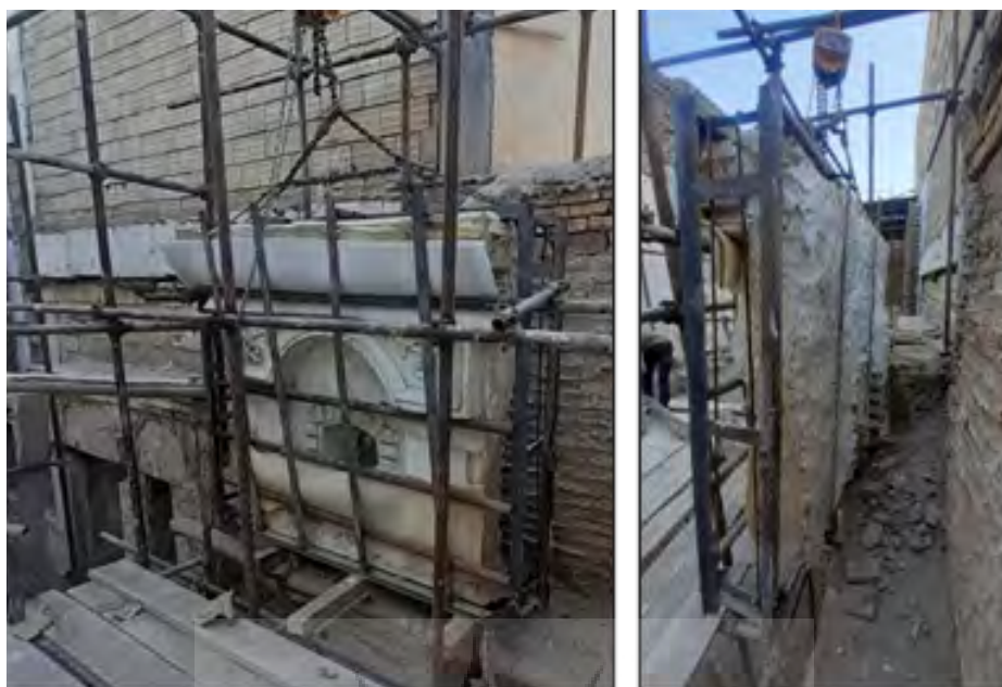
شکل ۲۶. خالی کردن پشت کار برای جدا نمودن اثر از تکیه‌گاه و مهار با جرثقیل
