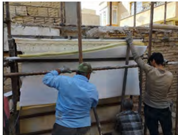
شکل ۱۲. پوشش‌دهی روی شومینه با استفاده از ابر و فوم
