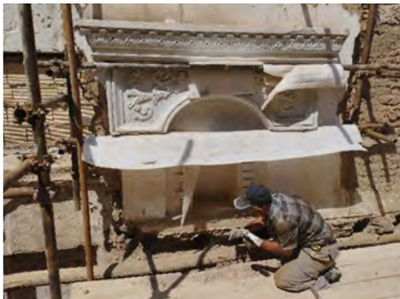
شکل ۱۳. ایجاد شمع کوبی در بخش تاج شومینه
