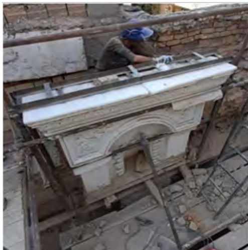
شکل ۲۲. آخرین مرحله اتصالات قاب فلزی
