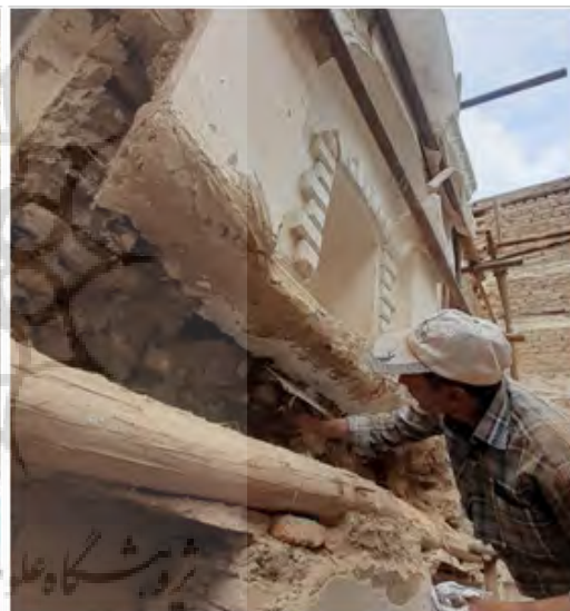
شکل ۱۴. شروع تثبیت لایه های زیرین شومینه با گچ زنده. شکل ۱۵. ایجاد لایه محافظ با گچ زنده برای قرارگیری قاب فلزی به عنوان بستر (از راست به چپ)
