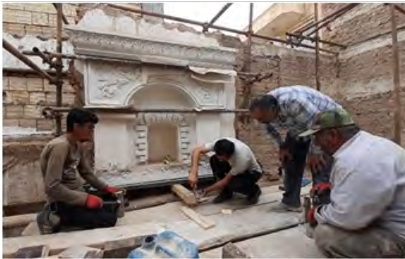
شکل ۱۷. جانمایی بستر فلزی در زیر کار
