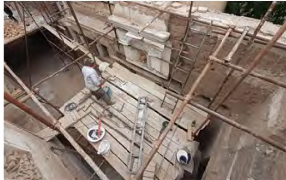
شکل ۱۶. ساخت بستر فلزی برای قاب بندی
