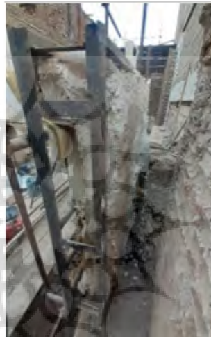
شکل ۱۸. تخریب بخشی از پشت کار و دیوارهای جانبی برای جاگذاری پروفیل. شکل ۱۹. تخریب پشت کار و اجرای قاب فلزی. شکل ۲۰. تکمیل قاب فلزی دور اثر (از راست به چپ)
