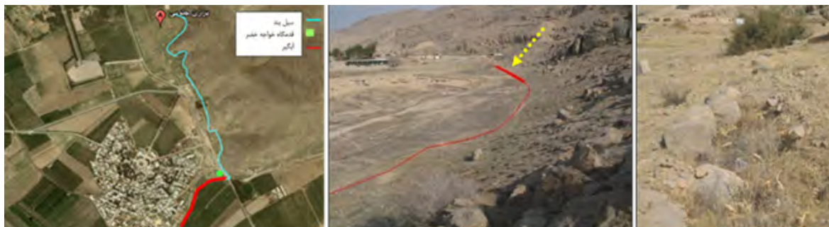
شکل ۴: تدبیر هخامنشیان به منظور جلوگیری از نفوذ سیلاب‌های کوهستان به درون شهر در قسمت مشخص شده پی‌سازی سیل بند قابل مشاهده است. موقعیت آبگیر شهرک زراعی و سیل بندهای شهر پارسه (نگارندگان، ۱۳۹۵)
