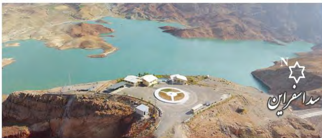
شکل ۲- سد خاکی بیدواز اسفراین (شرکت آب منطقه‌ای استان خراسان شمالی)
