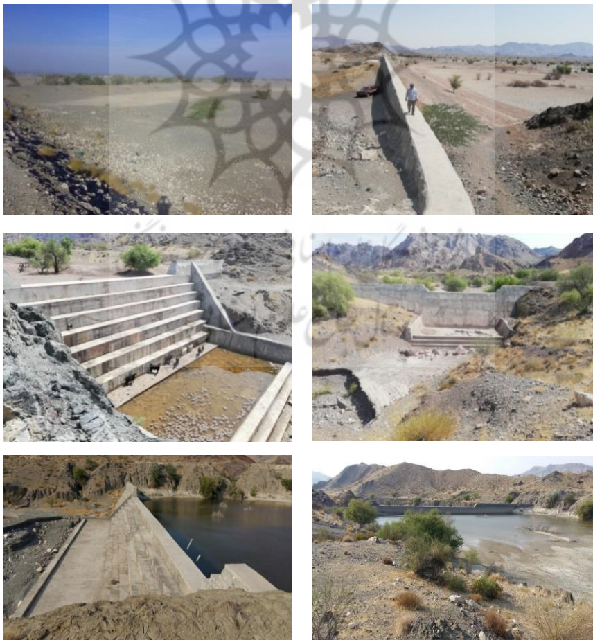
شکل ۲. برخی از سازه‌های موجود در حوزه
