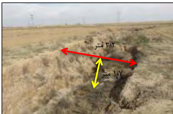
شکل ۱۲: شکاف ایجاد شده پس از فرسایش و بازشدگی
