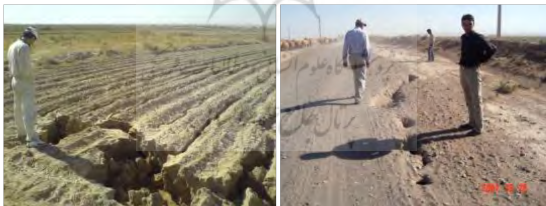
شکل ۱۷: نمونه از آسیب شکاف‌ها ناشی از نشست زمین در جاده و زمین‌های کشاورزی دشت نیشابور
