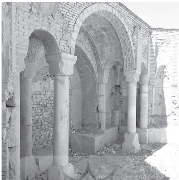
تصویر شماره ۶. آجرچینی قوس‌های سردر ورودی (نگارنده)
