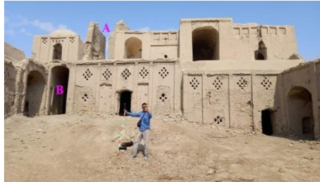
شکل ۲. آس باد در بخش اصلی (مرکزی) ورمال؛ A پرخانه و B آس خانه
