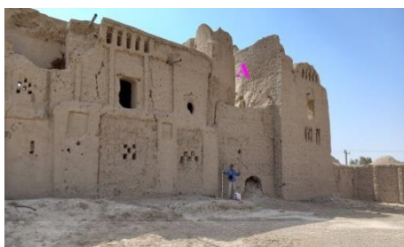
شکل ۴. دریچه ورودی باد به آس‌باد (A) و مجموعه ساختمان‌های ضلع شمالی بخش اصلی (مرکزی) ورمال
