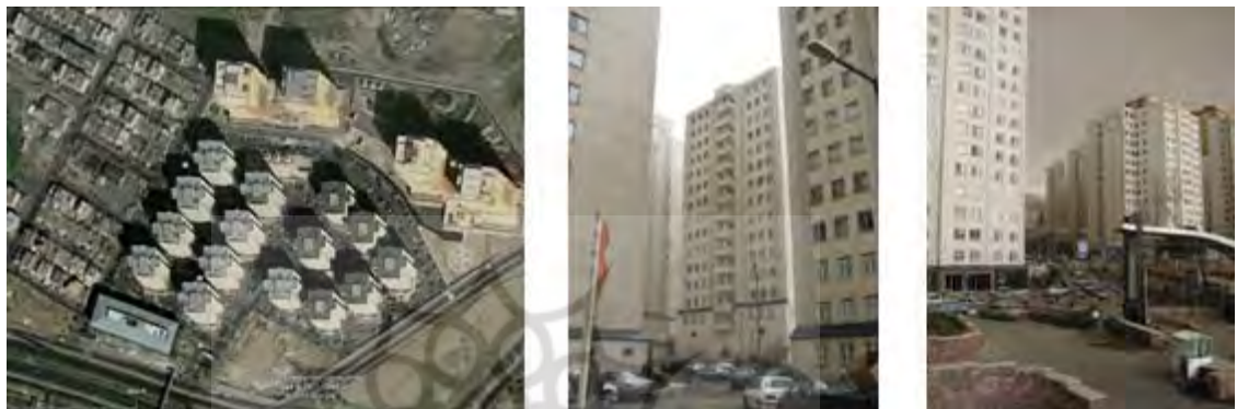
شکل ۵. مجتمع مسکونی کوثر: تراکم بیش از حد ساختمانی در یک زمین محدود و بلا استفاده بودن فضاهای بینابینی جز برای رفت و آمد و پارک اتومبیل؛ منبع: Google Earth و عکاسی در محل.
