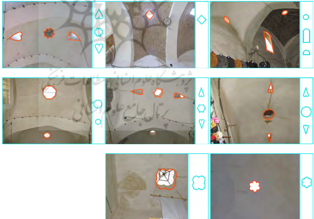
شکل ۱۵. نورگیری و تهویه در ساختار پوششی راسته بازار کاشان؛ ماخذ: نگارندگان، ۱۳۹۵
