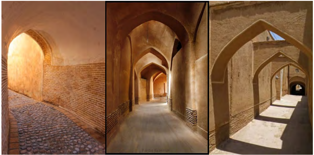
تصویر ۴. نقش ساباط؛ مأخذ: نگارندگان. (*) این سازه به دلیل نیمه پوشیده بودن به پدید آمدن کوران هوا می انجامد. در تابستان خنک، و در زمستان گرم می باشد.
