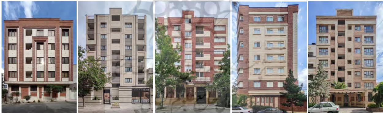
تصویر شماره ۲: تصویر برخی از ساختمان‌های نمونه جدیدالاحداث در محله حکیمیه با نمای ترکیبی
