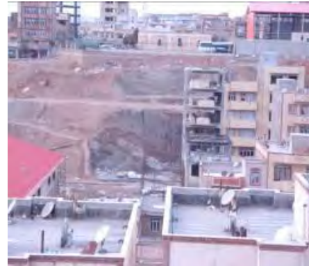
شکل ۵- نمونه ساخت‌وساز روی سازندها با لیتولوژی نامقاوم و منفصل که در ترانشه ایجادشده تناوب مارن‌های آهک‌دار و ماسه‌سنگ با میان لایه‌های آهکی مشهود است ساخت‌وسازهای فوق دقیقاً در ضلع جنوبی سازند فوق است.
