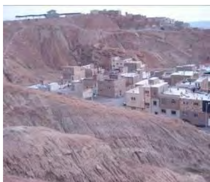
شکل ۴- نمونه ساخت‌وساز در دامنه تپه‌های منفرد مارنی و رسی با شیب تند و در معرض خطر ناپایداری کامل دامنه‌ای
