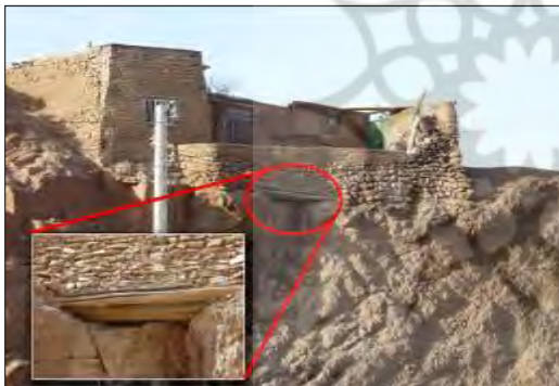
شکل ۸- نمونه‌ای از ساخت‌وساز غیرمجاز که نشانه دخالت انسان در تشدید فرایندهای مربوط به ناپایداری است.
