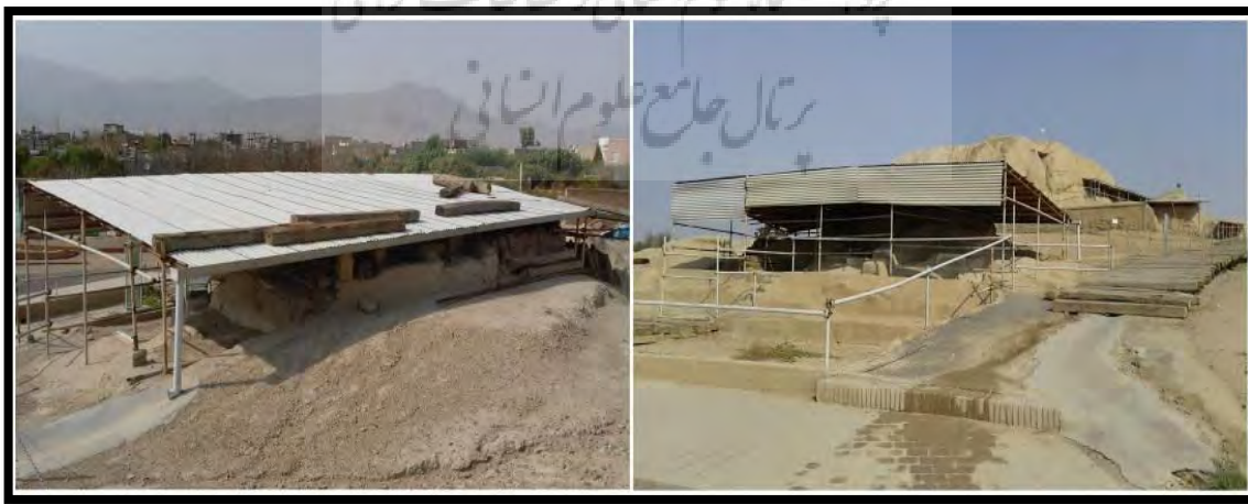
تصویر ۱. سایت موزه سیلک. سازه حفاظتی از جنس ایرانیت، مسیرهای دسترسی چوبی و سنگ‌فرش، آبراهه‌های سیمانی (نگارندگان)
