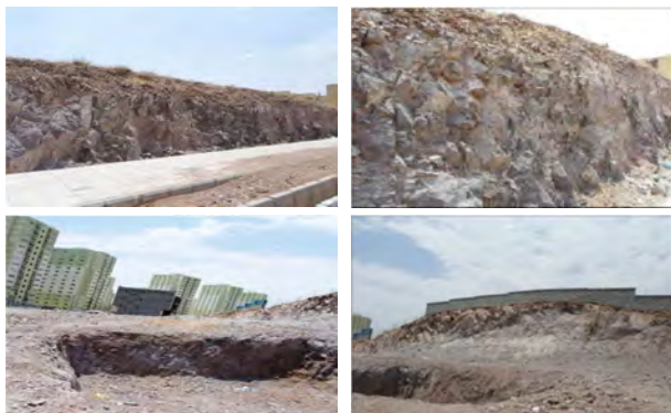
شکل ۵: خردشدگی شدید سازندهای سنگی در اثر گسلش
